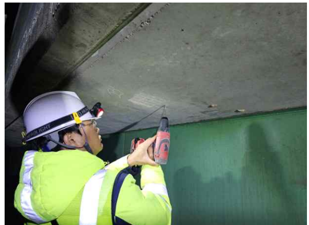
탄산화깊이 측정 현황
